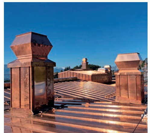
Glänzende Arbeit der Architekten und Dachdecker: Das neue Kupferdach der Berner Klinik Montana.
